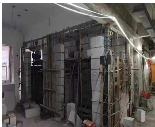
电梯间墙体砌筑
