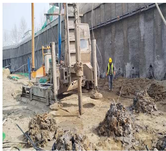
抗浮锚杆施工
