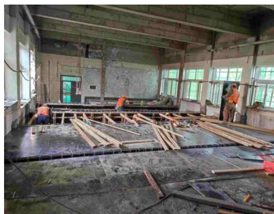
模板支模作业
