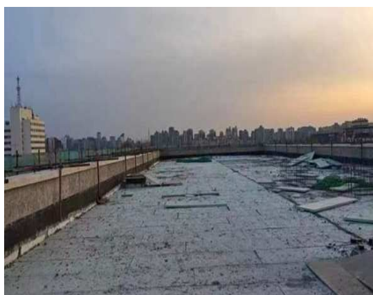
屋面防水及保护层拆除
