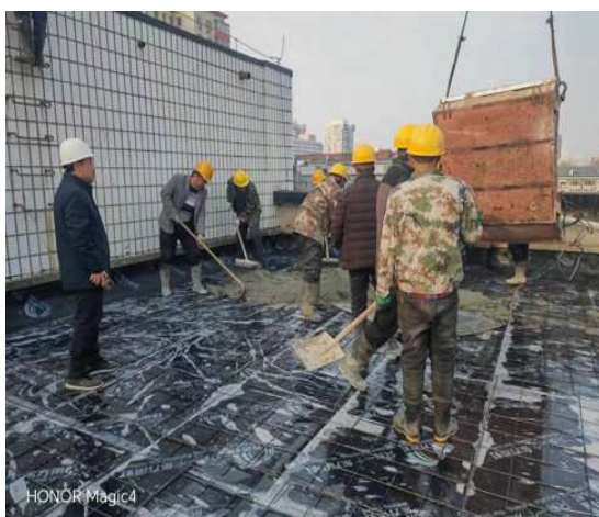
屋面防水施工
