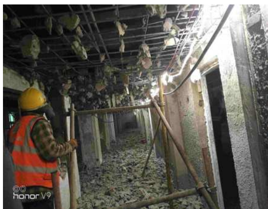
屋顶拆除作业
