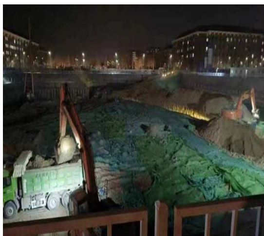
土方挖运作业
