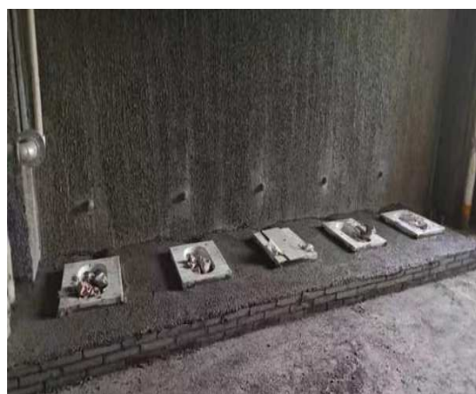
卫生间洁具安装
