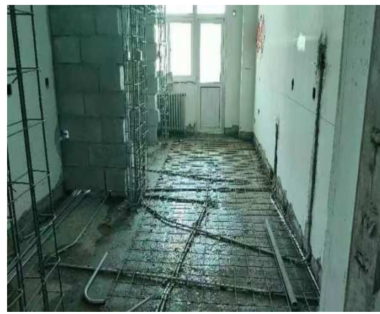
室内地面钢筋绑扎
