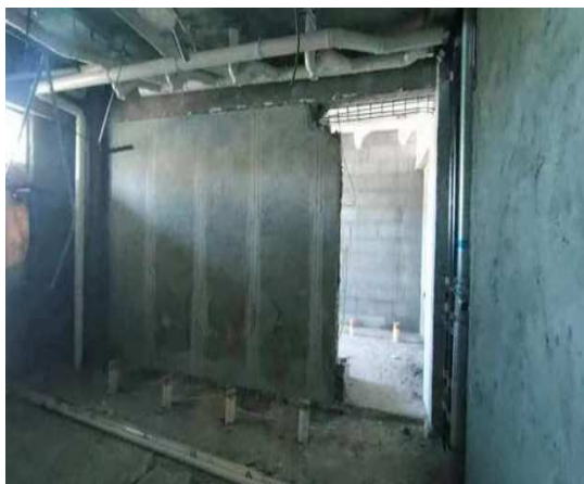
卫生间管道布设
