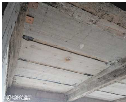
顶板拆除作业
