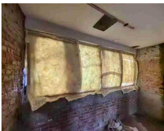
屋顶拆除施工
