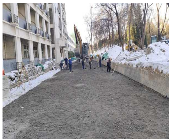
道路二灰铺设
