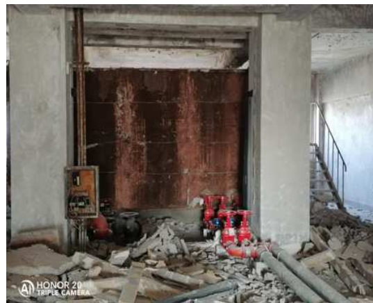
管道拆除施工
