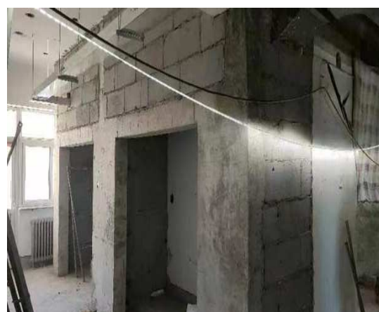
设备间砌筑施工
