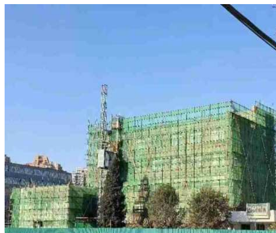
室内拆除施工
