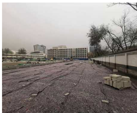
地面基层养护
