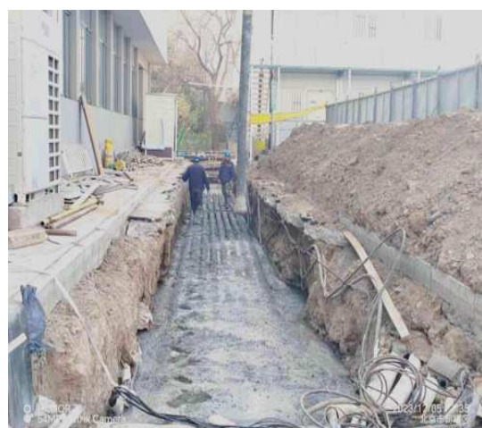
室外电力管线包封作业
