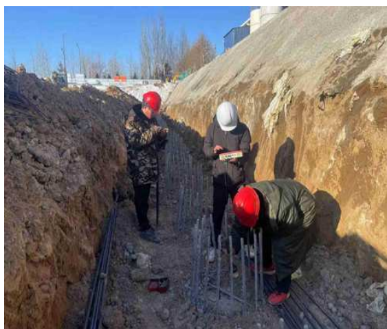
支护桩完整性检测
