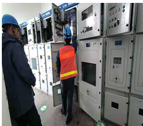
配电室高压柜安装调试
