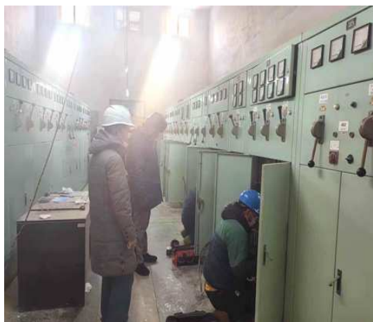
配电室低压配电柜切改
