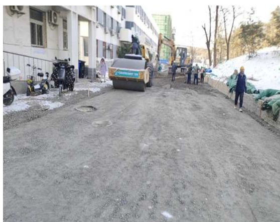
路床碾压作业
