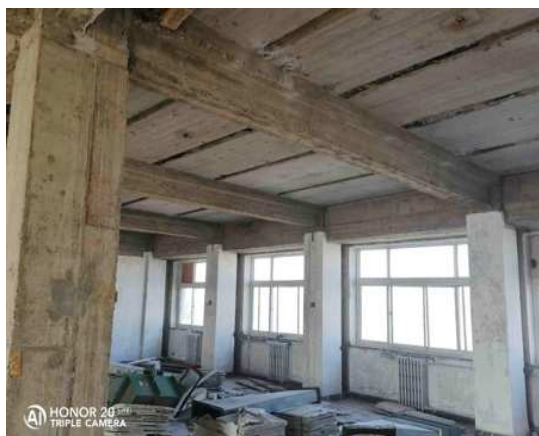
吊顶梁拆除施工
