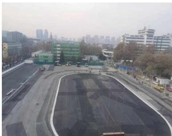
运动场铣刨基层处理施工
