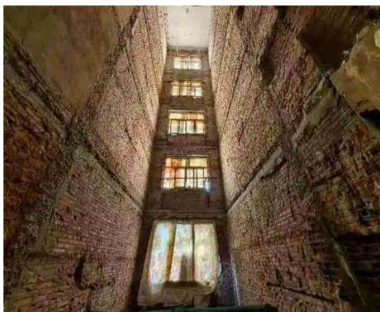
外墙剔除施工
