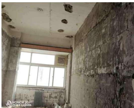
墙体拆除作业
