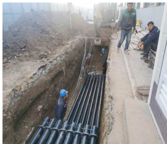
室外电力直埋管铺设施工
