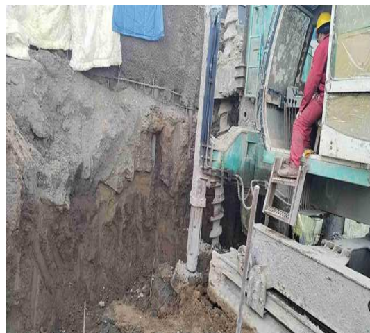
现场旋喷桩、帷幕桩施工
