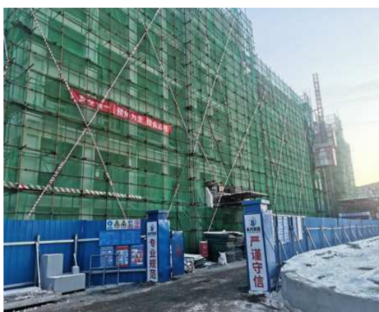
现场临时设施建设
