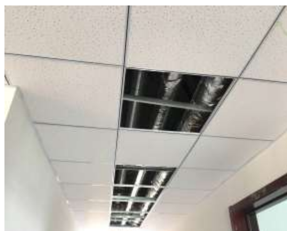
楼内吊顶施工
