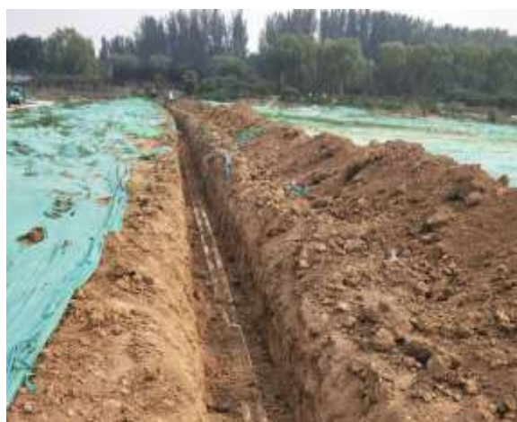
弱电管线施工
