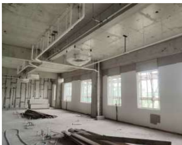
VRV 空调内机安装
