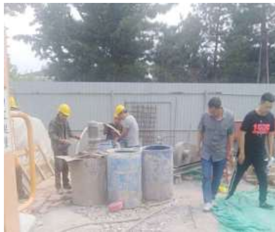
现场注浆材料加工
