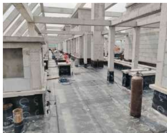
屋顶防水施工
