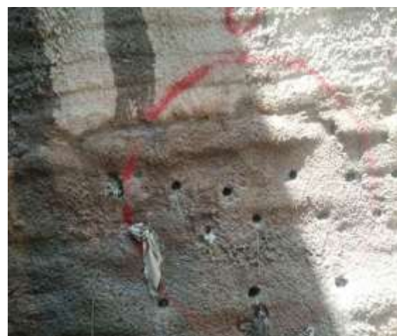
顶管注浆打洞
