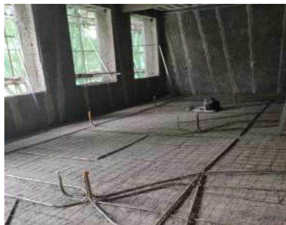
基础楼首层垫层绑筋完成
