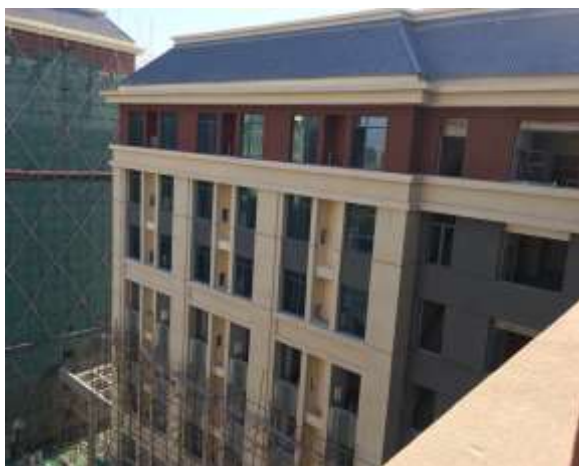
外墙真石漆施工
