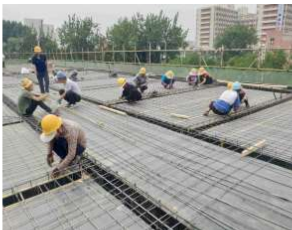
学六楼屋面绑筋
