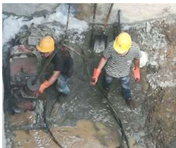
接收坑下作业
