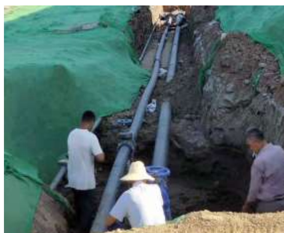
压力水管线施工
