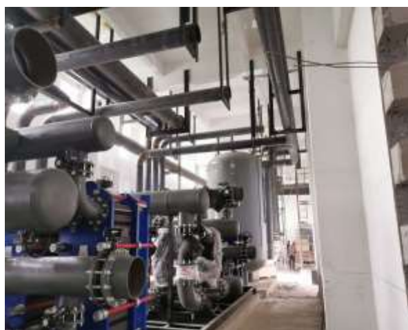
锅炉板换机组安装
