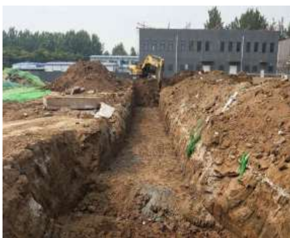
雨水管线开槽施工
