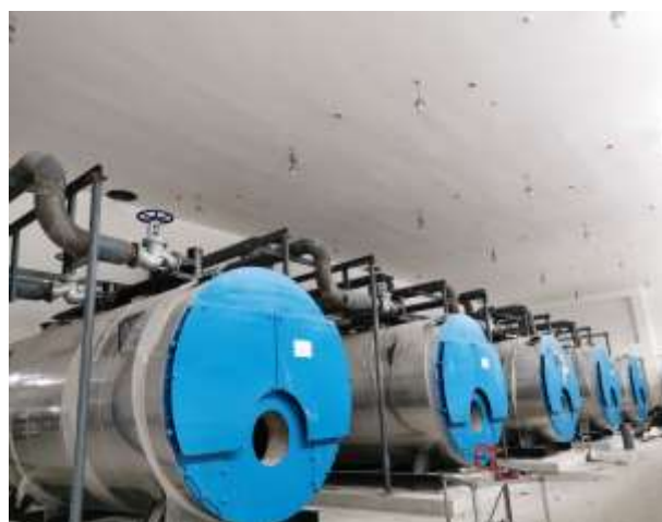
锅炉机组设备安装
