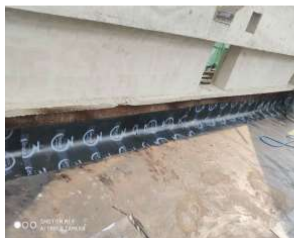
女儿墙防水接茬施工
