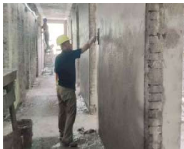
内墙抹灰施工
