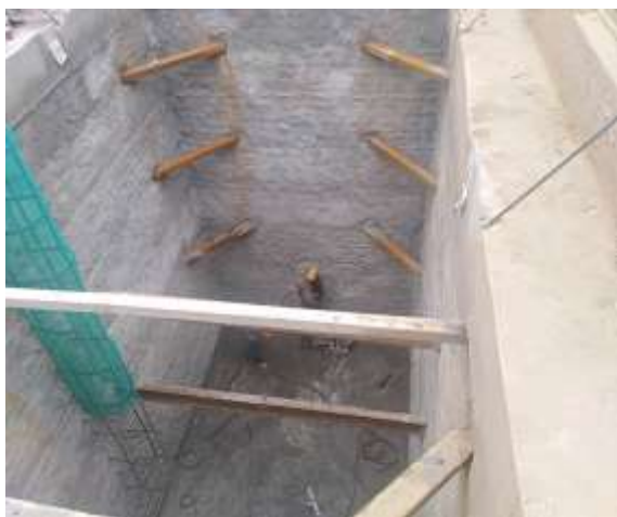
注浆止水作业
