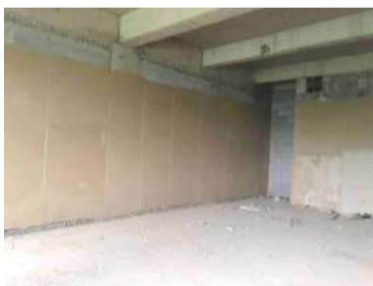
墙体抹灰施工
