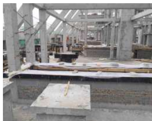
屋顶防水施工
