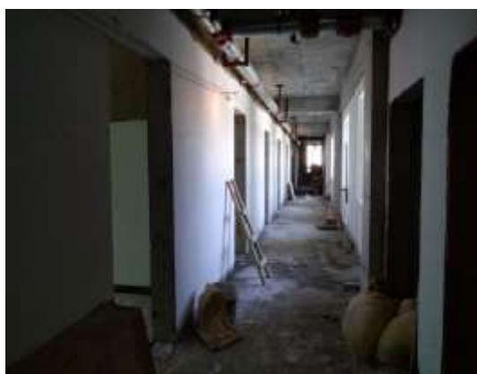
消防管道安装
