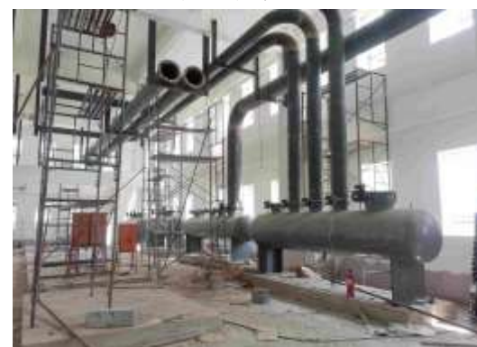
锅炉设备管线安装
