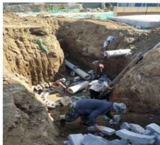
污水管线、井室施工
