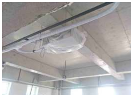
空调盘管安装
