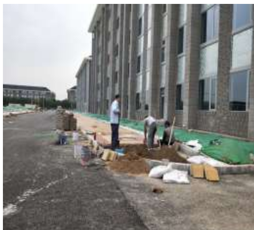
西区环路步道铺设
