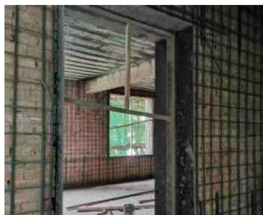
基础楼门洞支模
