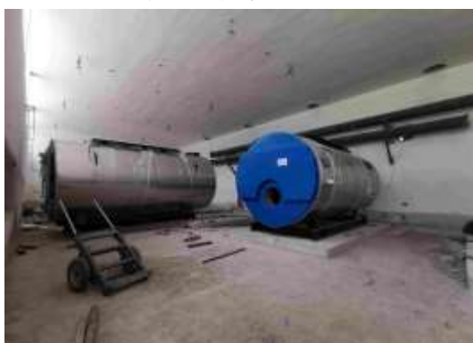
锅炉设备安装
