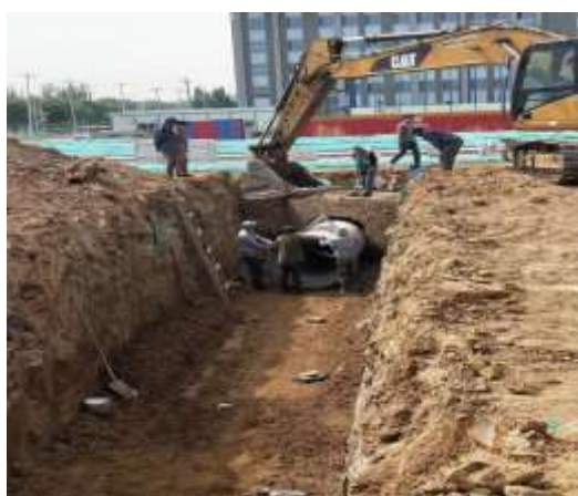
中心区雨水管线施工
