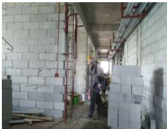
二次结构墙砌筑
