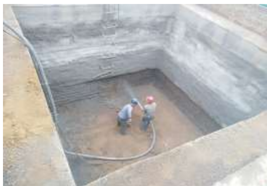
顶管坑喷锚施工
