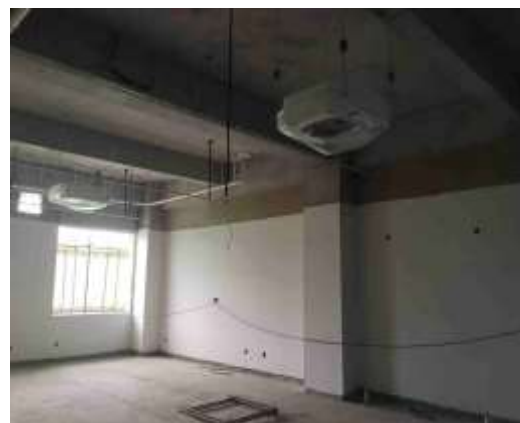
通风机口安装
