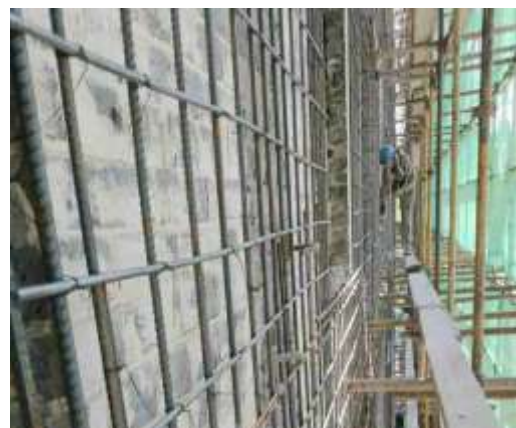
学六楼外墙绑筋
