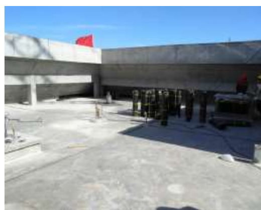
屋顶防水施工
