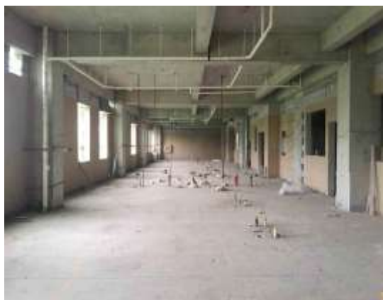
VRV 空调风机盘管安装
