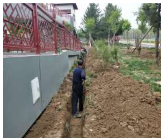
东西两院弱电管线连接
