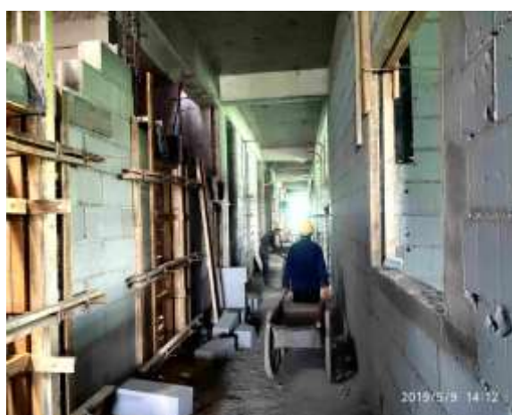
二次结构墙砌筑
