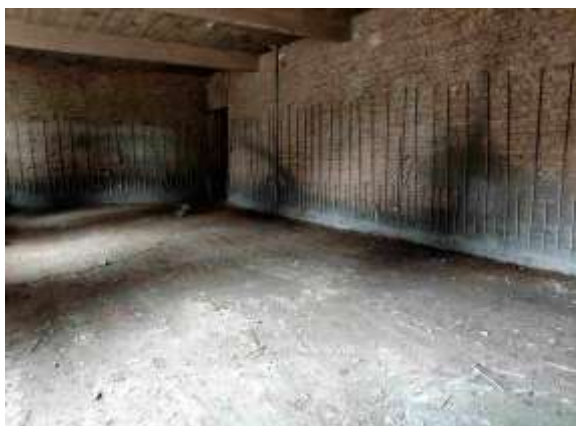
室内回填土完成
