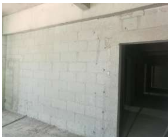
二次结构墙砌筑
