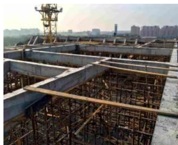
花架梁施工完成
