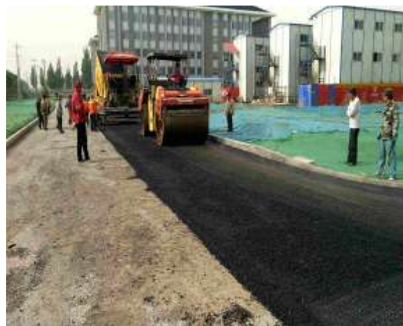
沥青混凝土摊铺
