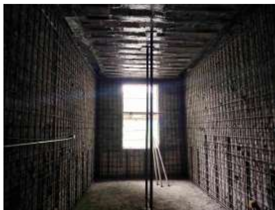
内墙钢筋绑扎
