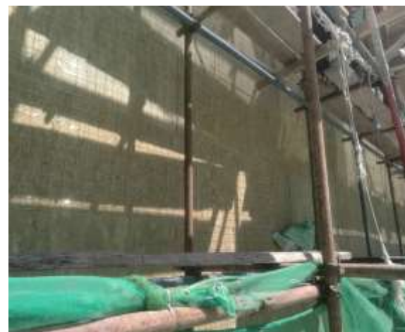
外墙保温施工
