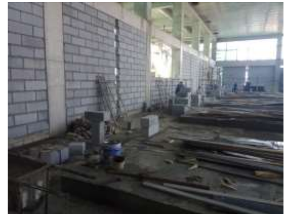
锅炉设备基础支模
