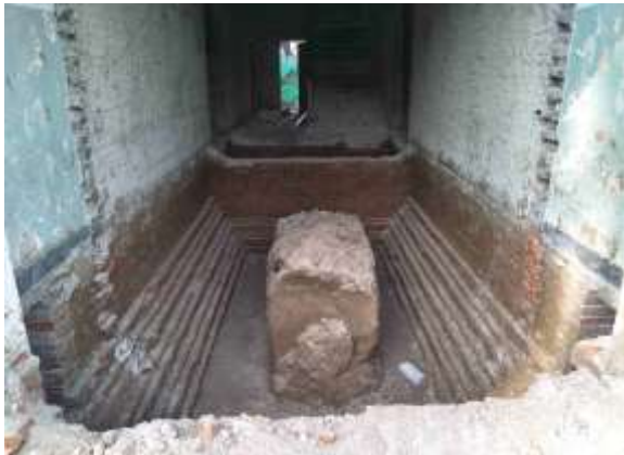
学六楼基础清槽
