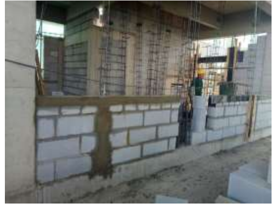
二次结构柱筋绑扎
