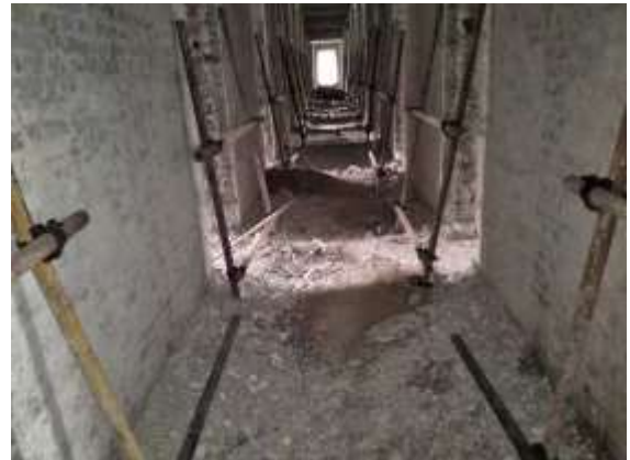
走廊地面剔槽
