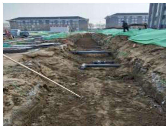
强弱电管线铺设
