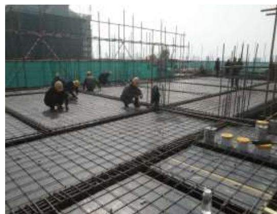
北楼主体顶板钢筋绑扎
