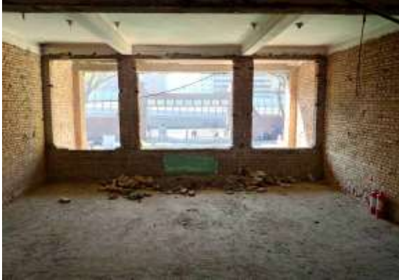
基础医学院楼主体拆除
