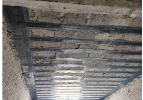
屋顶碳纤维加固
