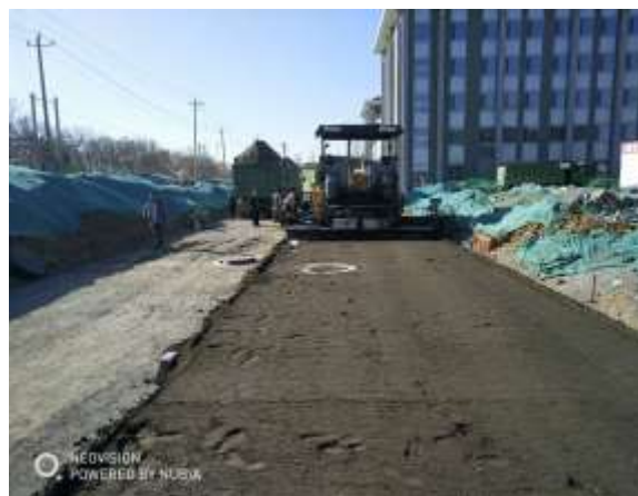
二灰层铺设碾压
