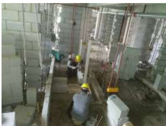
二次结构墙砌筑
