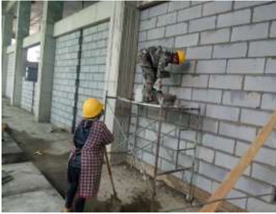
二次结构墙砌筑
