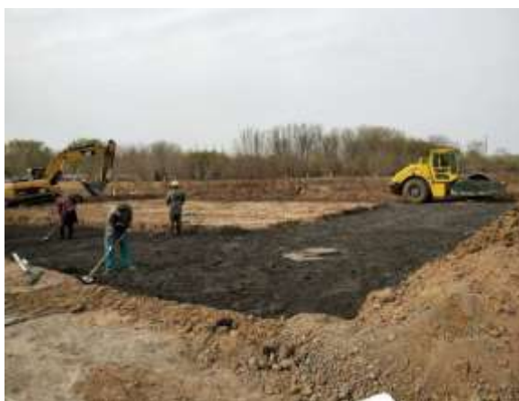
西二路换填土施工
