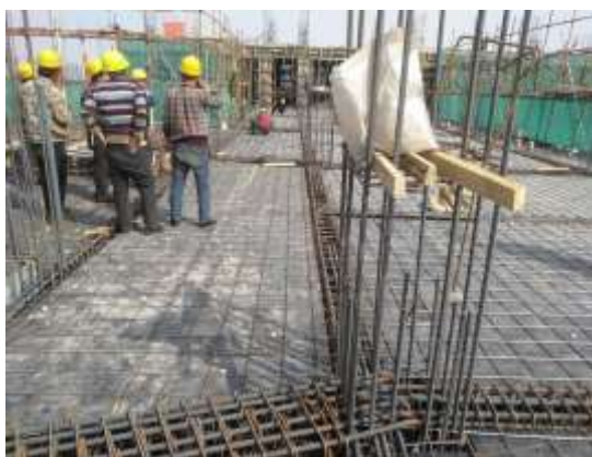
北楼主体钢筋柱绑扎
