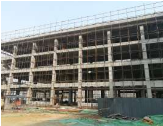
基础土方回填
