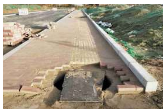
污水井口砌筑
