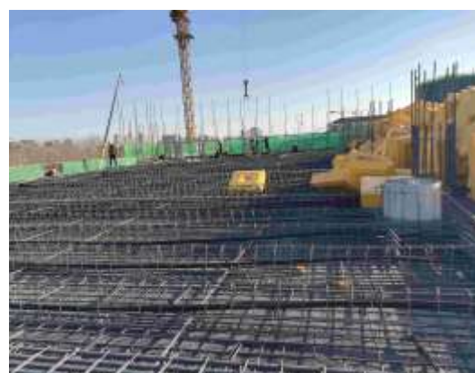
预应力梁施工
