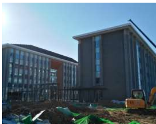
室外小市政施工
