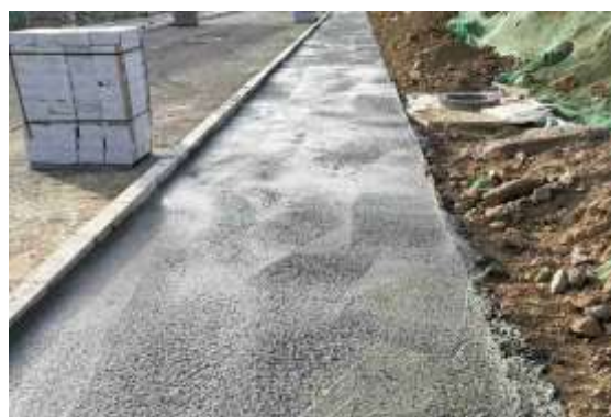
步道基础施工
