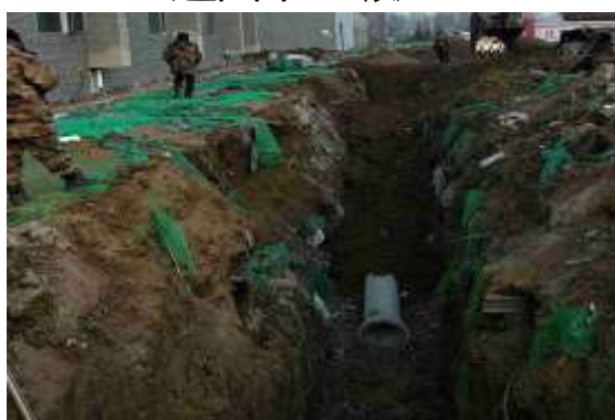
污水管道安装
