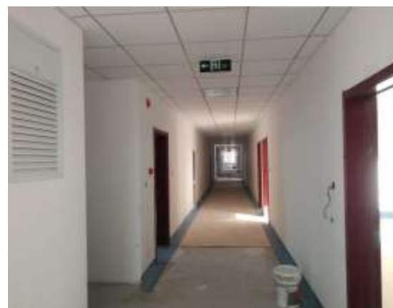
走廊地胶铺设
