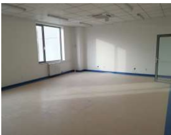
室内地胶铺设
