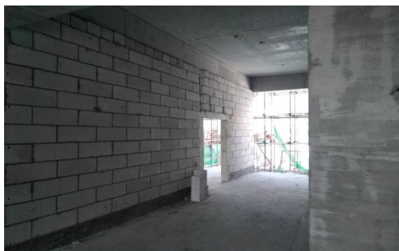
二层结构墙砌筑
