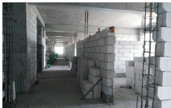
二层结构墙砌筑
