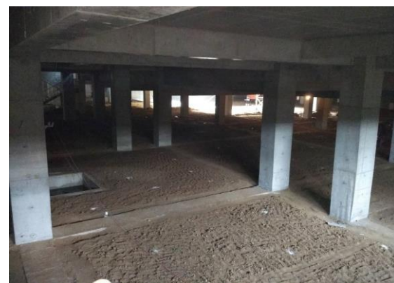
地下部分施工
